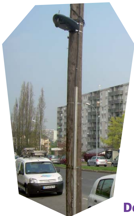
Station de mesure implantée à Ris-Orangis (91) pour le suivi du bruit routier
